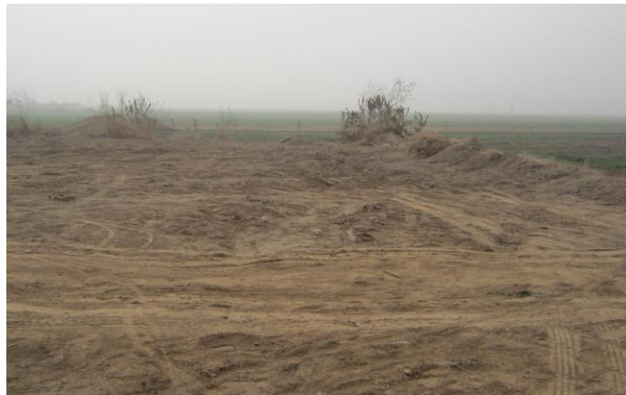
泥浆池固化覆土后照片
